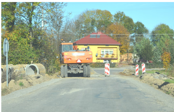
Trwa przebudowa drogi Tworyczów–Kitów
