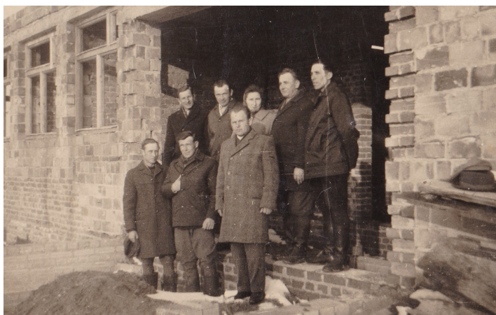
Budowa szkoły w Tworyczowie 1974 r.
