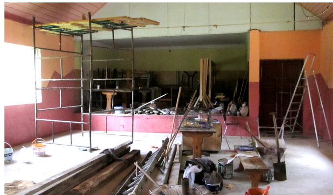
Remiza w trakcie pierwszego remontu
