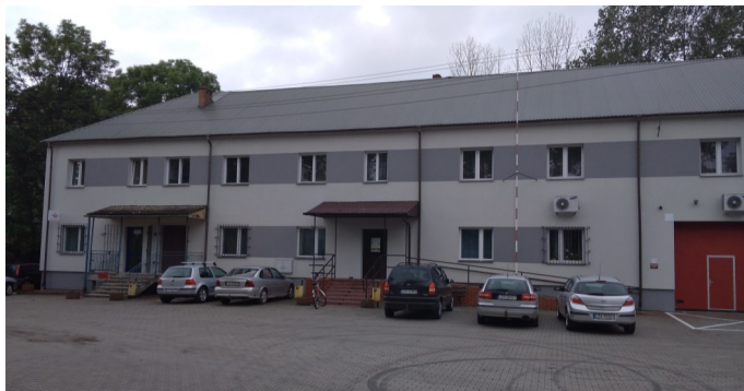
Nowa elewacja budynku remizy w Sułowie
